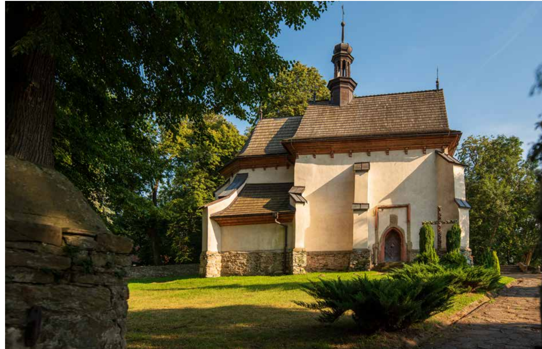
Kościół pw. Św. Bartłomieja, Zbyszyce ↑ Church of St. Bartłomiej, Zbyszyce Kostol Sv. Bartłomiej, Zbyszyce
